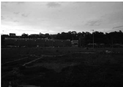
住宅の基礎が破壊されたままの状態 津波被害の大きさが伺える。
