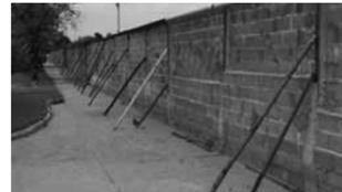
まだ記憶に新しい、タイ洪水の爪あと。突貫工事でブロック塀を作り、24時間体制で隙間から漏れくる水をセメントで塞いで進入を防いだとのこと。
