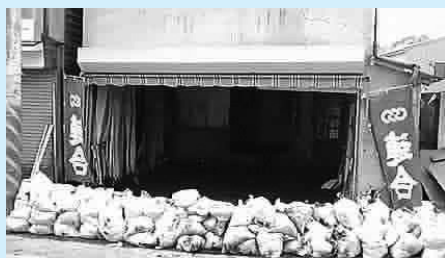
泥だし作業場所
